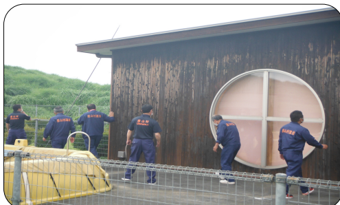
産山保育園外壁修繕
