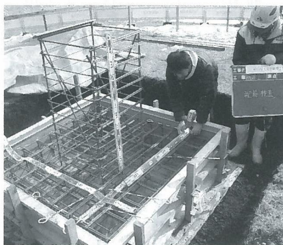
《天文台基礎工事》
