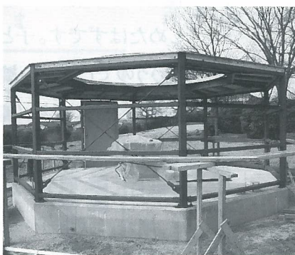
《八角形の鉄骨基礎設置》
