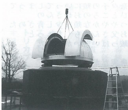
《天文台ドームの設置》
