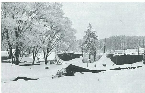
雪の重みにより倒壊した鶏舎の様子
