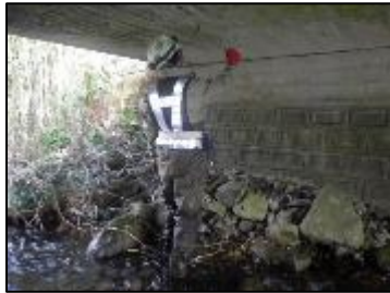
図-3 近接目視点検の様子
