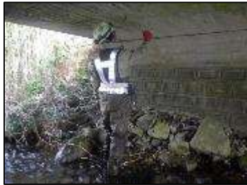
図-3 近接目視点検の様子
