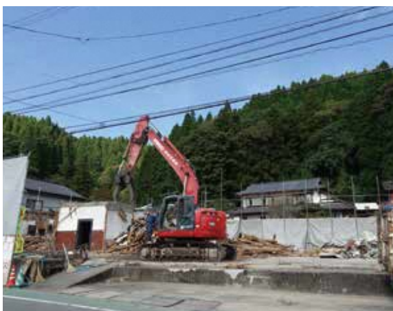
解体工事の様子
