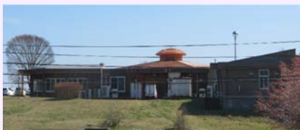
落雷により何度も電気設備が故障した牧场交流館
