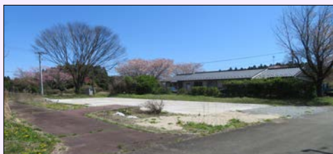
2棟が建築される大利団地
