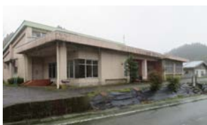
田尻地区公民館の外壁塗装が剥がれた外壁天井
