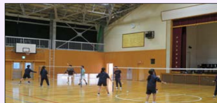
空調設備が設置される産山学園体育館
