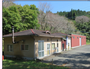
産山村水工場施設
