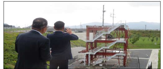
東日本大震災二より鉄骨だけ庁舎となった防災対策庁舎
