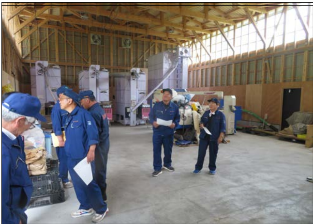
令和6年度に完成した農事組合法人弁財天の米乾燥倉庫調整施設
