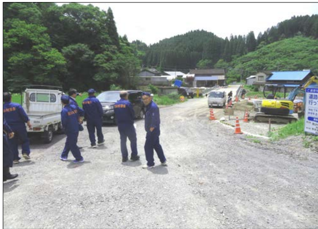
改良工事が進む村道産山・田尻線飛瀬地区
