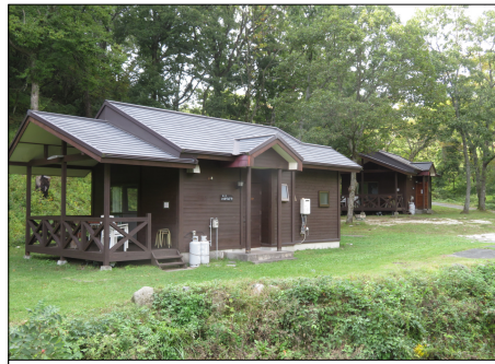
現在、携帯電話やインターネット等の通信環境が不安定なヒゴタイ公園キャンプ村ロッジ
