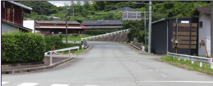
白線が消え、道路車線がわからない状態の村道産山・田尻線
