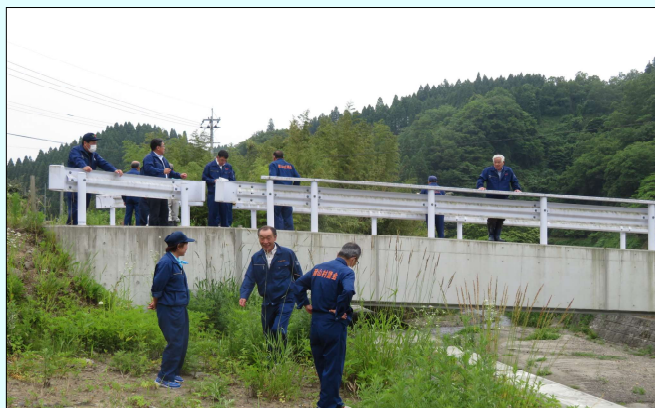
県道南小国波野線（牧野地区）の改良状況を視察
