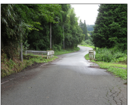
橋梁及び道路の改良行う村道山鹿大利線下家壁橋
