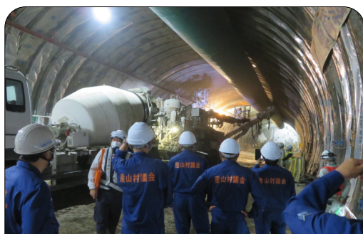
写真は、本坑で現在掘削工事の状況
