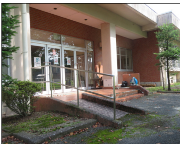
各地区公民館の玄関には、スロープが設置されており、写真は田尻地区公民館
