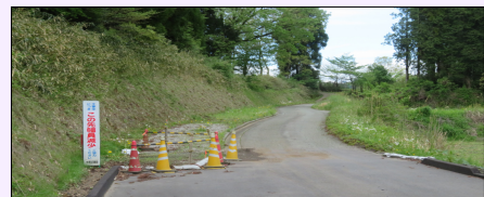
写真は、改良工事が進む村道片俣・菅生線
