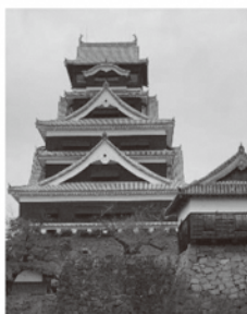
▲ 「空中回廊」から望む 完全復旧した天守閣
