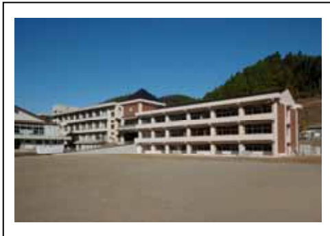
中学校と連結した校舎
