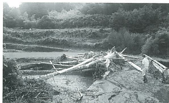
橋の欄干で止った流木。大利を直撃した。
