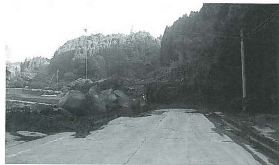
山側から県道に落下した巨石。道路を寸断し、復旧作業も困難を極めた。
