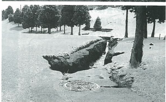
やまなみゴルフ場のコース内の各所で洪水が発生した。
