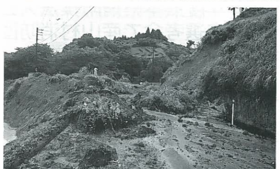
御湯船温泉館へ向かう村道に土砂崩れ。左下段の田まで土砂が流入。
