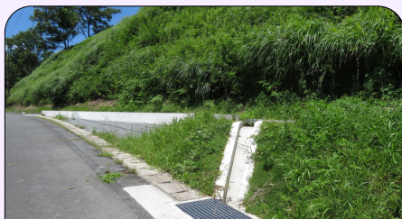
令和4年改修を行った産山地区 中新井手水路
