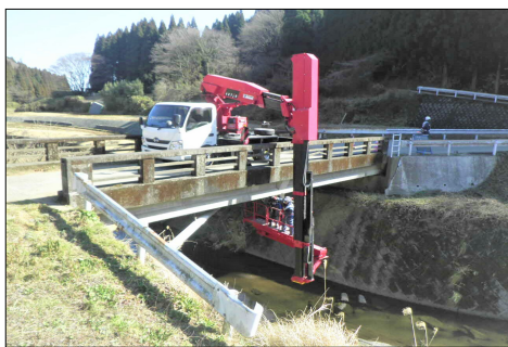
橋梁点検を行った片俣橋
