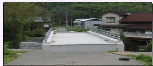
村道産山田尻線飛瀬橋架け替え工事
